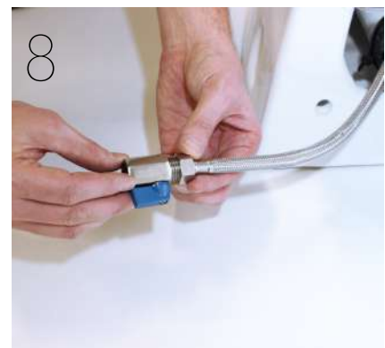
8 The very last step of the installation is connection the water. Test-flush the WC before first usage. Det allra sista steget i installationen är att ansluta vattnet. Test-spolä WCn innan förstaanvändning.
