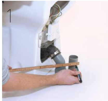
1 Measure the pipe in the floor. Mät röret som sticker upp i golvet.
