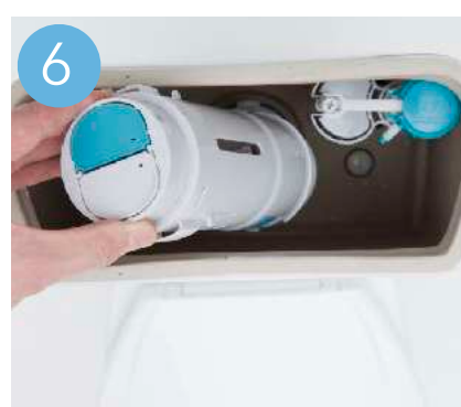
6. Lift up flushing equipment / Lyft upp spolustrustningen
