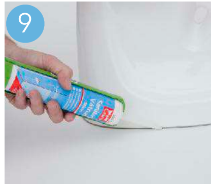
9. Use bathroom silicone to secure the toilet / Använd badrumssilikon för att säkra toaletten.
