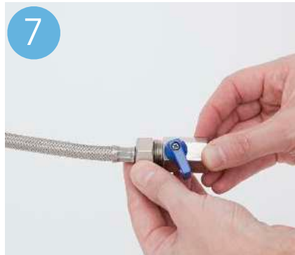
7. Turn on incoming water. / Sätt på inkommande vatten.
